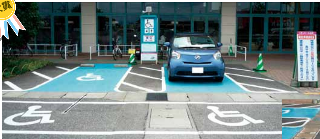
障害者専用駐車区画の標識・表示
